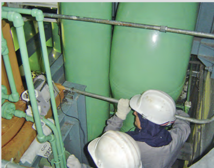
Figura 1. Ultrasonidos en inspección en servicio
