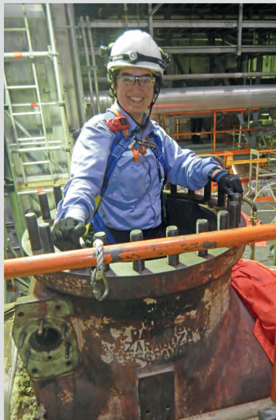
Figura 8. La autora accediendo al interior de tubería por válvula
