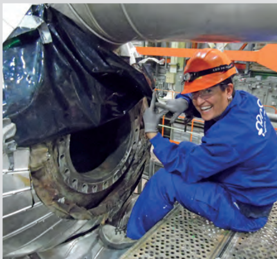
Figura 3. La autora realizando inspección visual en intercambiador de calor
